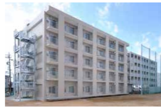
浜松国際交流会館2号館
